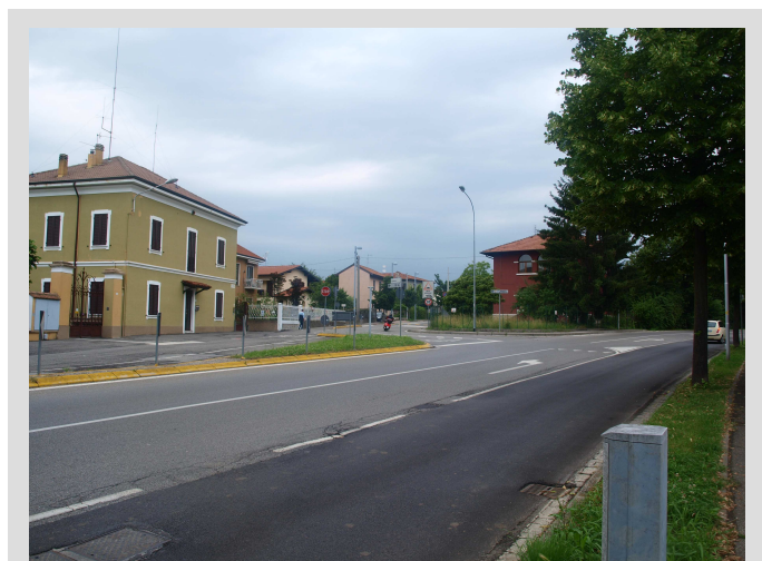
L’intersezione tra via Monza e via Resegone non dispone di attraversamenti pedonali protetti.
