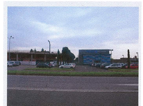
I varchi presenti fra gli edifici commerciali potrebbero essere utilizzati come percorsi di uscita dal piazzale.
